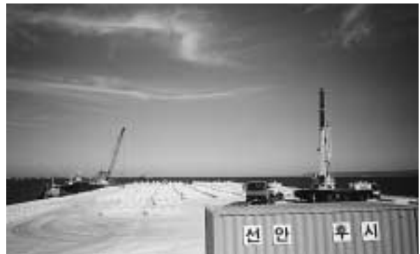
(写真4) 建設中の新浦項港
