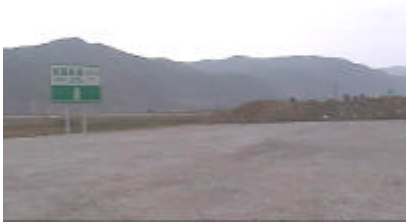
建設が進む長春 - 琿春高速道 (写真は延吉 - 図們間)
