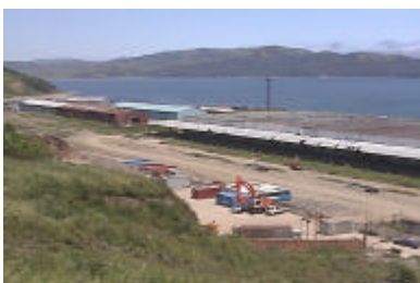
冷凍・穀物倉庫とコンテナヤード
