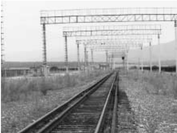
写真1 カミショーバヤ積替え駅 広軌（ロシア）と標準軌（中国）のレールが併設されている。
