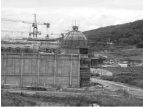
写真4 経済開発特区における中国側の建設状況(ロシア側国境より)
