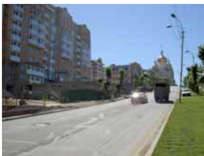
写真：建設が進む高級アパート
