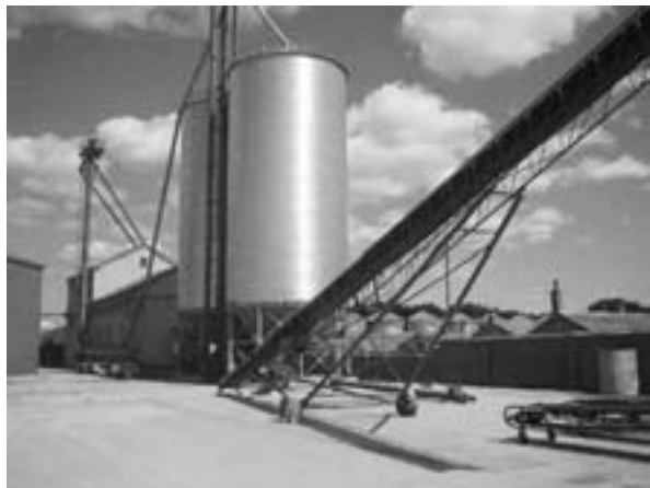
写真7 未調製もみの一時貯蔵施設
