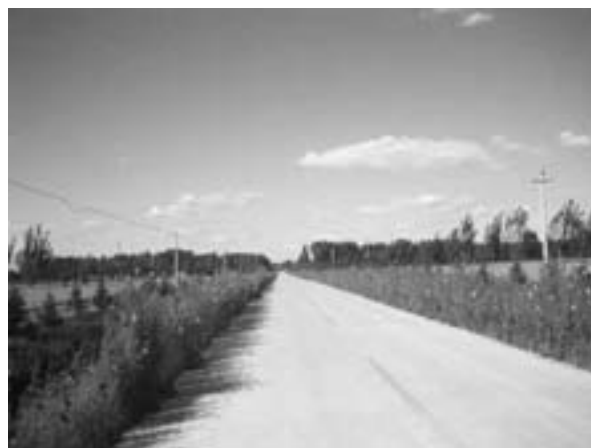
写真2 舗装された農道
