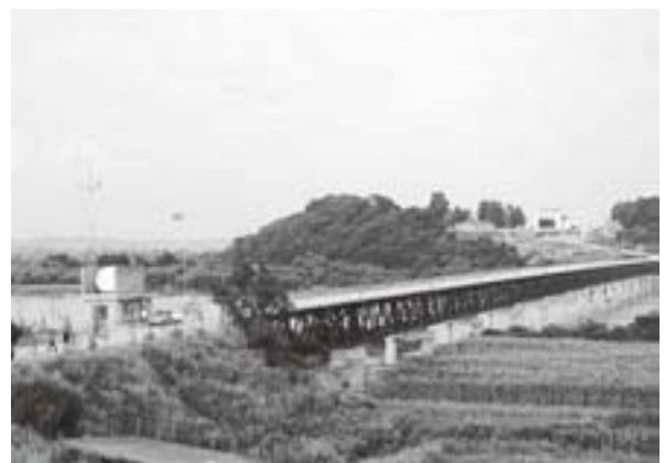
写真2 圈河橋（元汀橋）の全景
