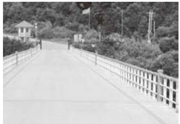
写真1 修復後の元汀橋（圈河橋）の路面
