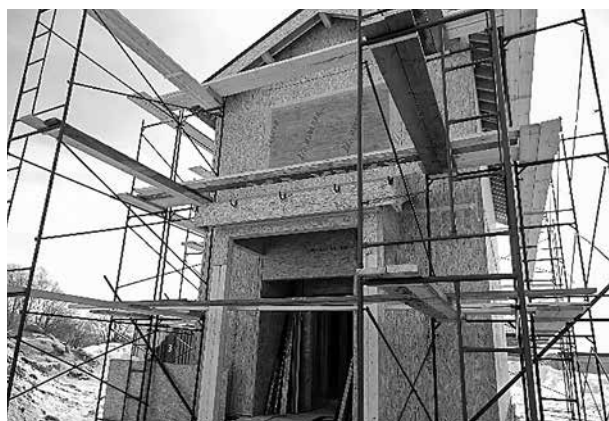
図3 カザン市郊外での住宅建設現場
